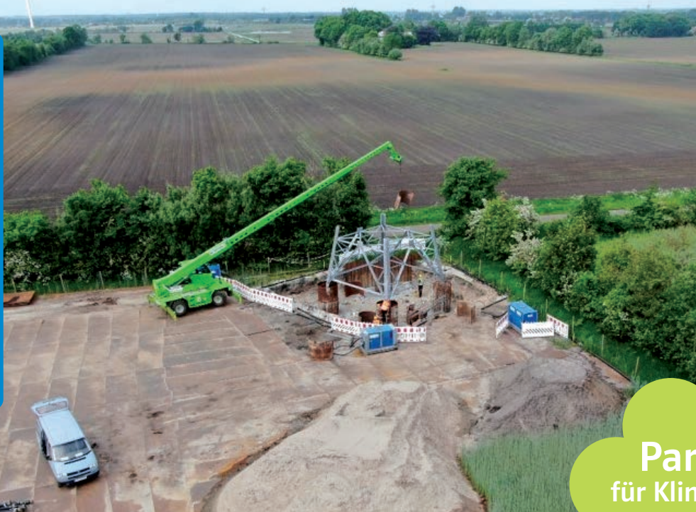
Mastbaustelle einer 110-kV-Freileitung
