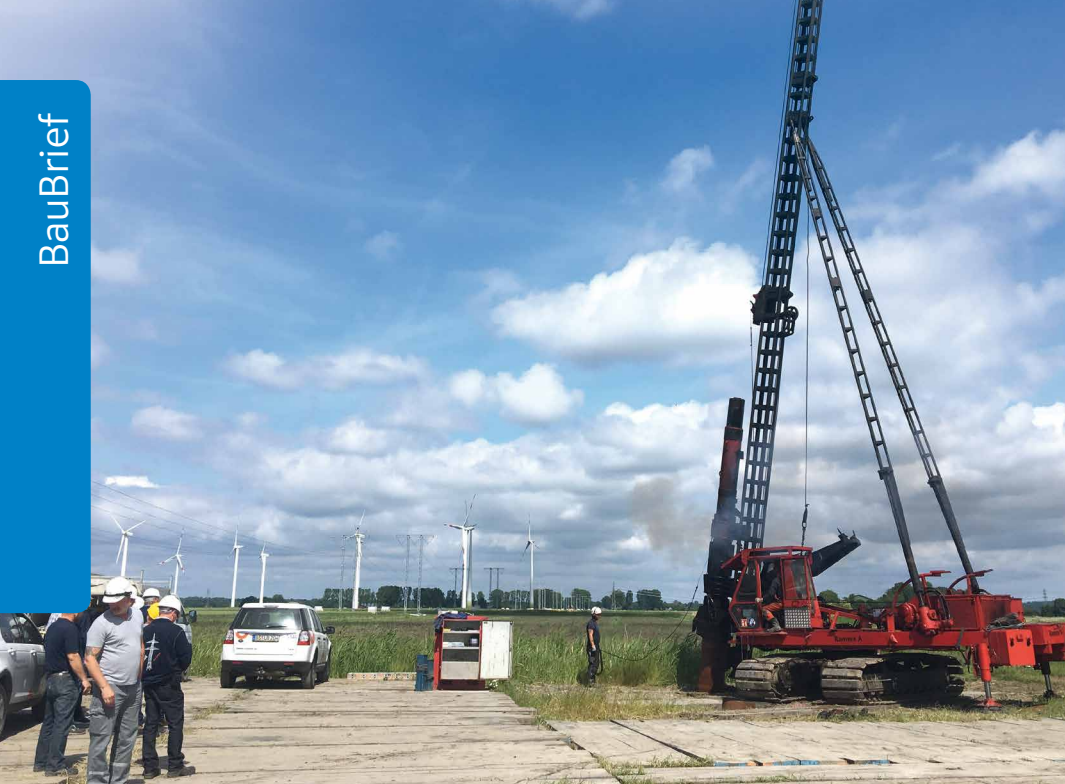
Rammarbeiten beim Bau der 110-kV-Freileitung Marne/West – Süderdonn
