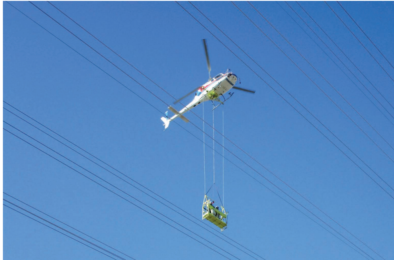
In luftiger Höhe werden Vogelschutzmarker an den Erdseilen montiert
