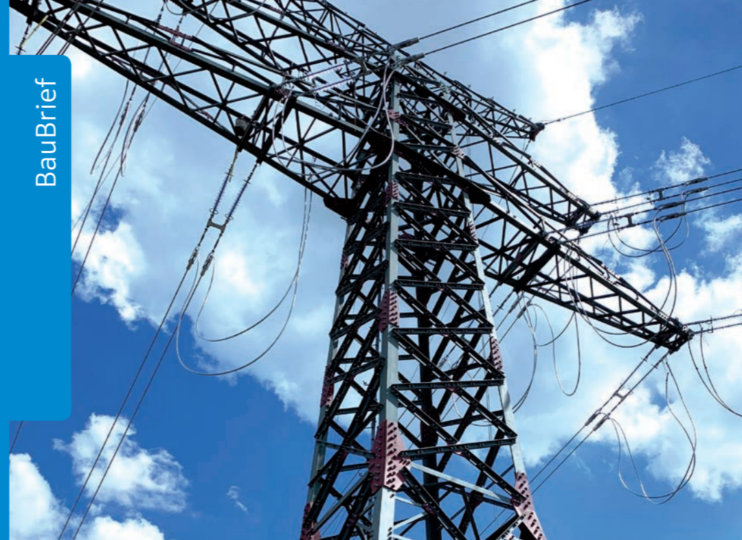
Einer der neuen, frisch beseilten Masten der 110-kV-Leitung Heide – Heide/West – Strübbel (Quelle: Prognos AG)
