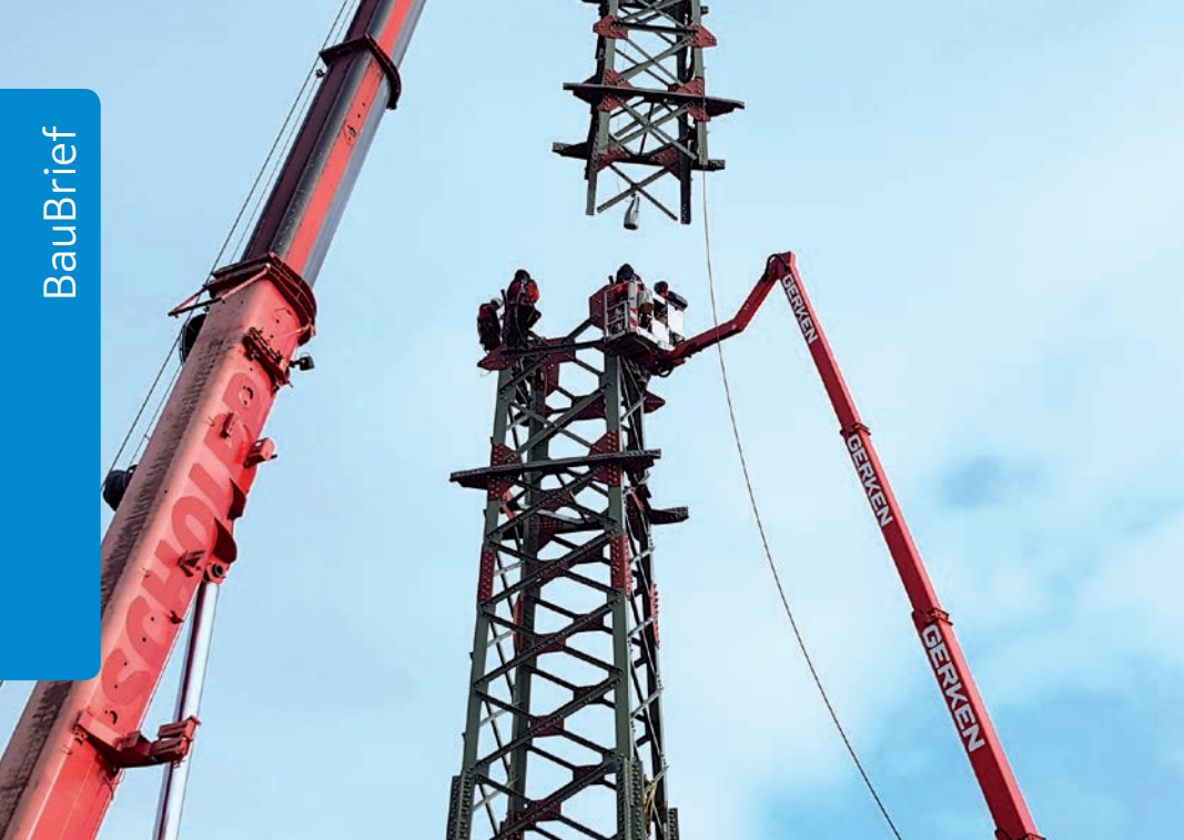
Ein Kran errichtet den Mast Stockwerk für Stockwerk
