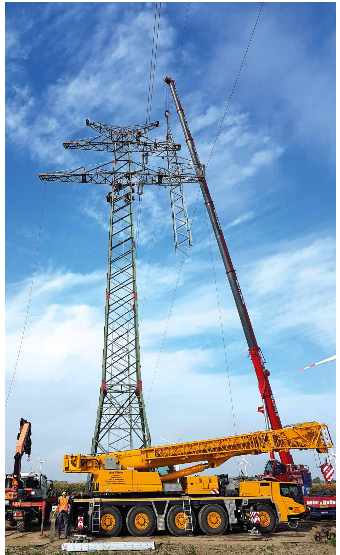
Die alte Mastspitze hängt noch am Kran. Der neue steht bereits.
