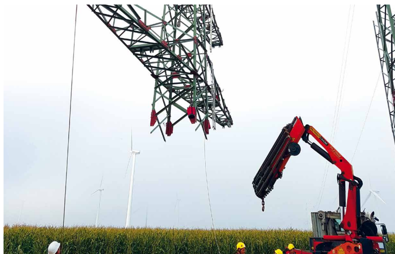
Die Spitze des neuen Mastes wird mit einem Kran nach oben gehievt.
