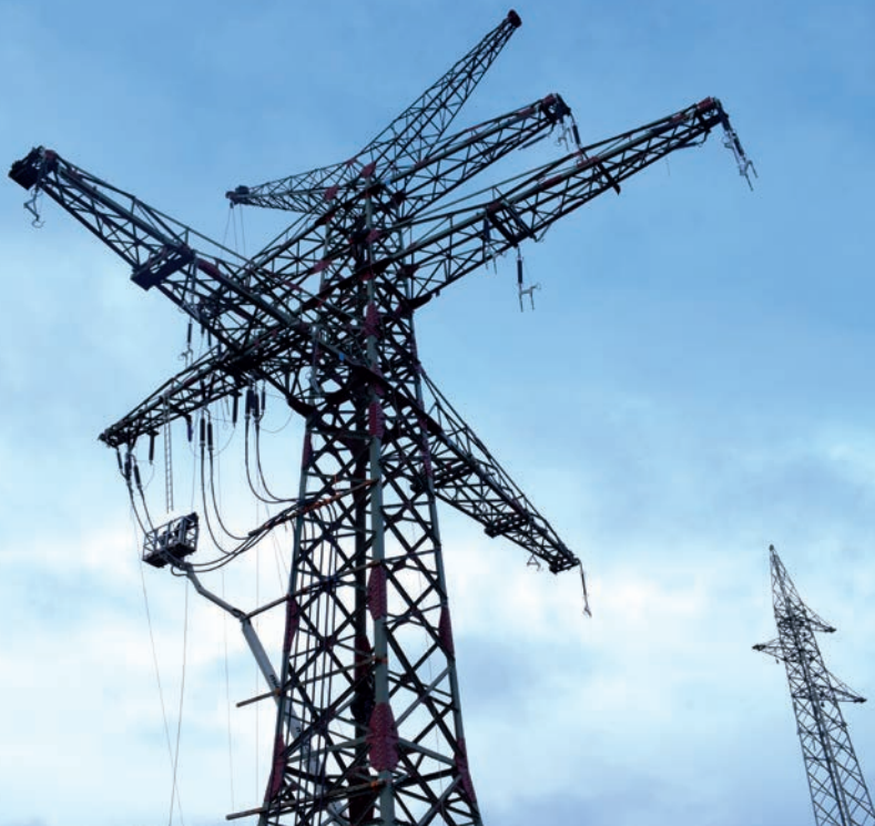
Mast 50N vor dem Umspannwerk Reinsbüttel
