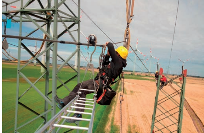
Die Monteure müssen schwindelfrei sein | Quelle: LTB
