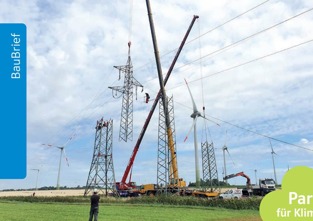
Maststockung mit Mobilkran | Quelle: LTB
