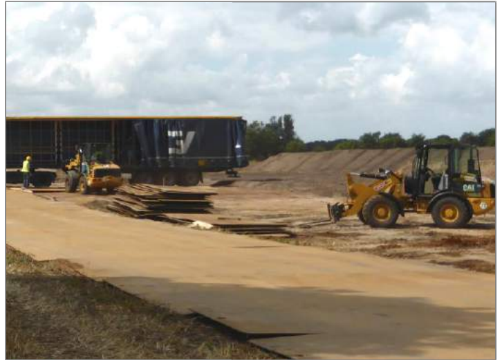
Die angelieferten Baggermatten werden zur Baustraße ausgelegt.
