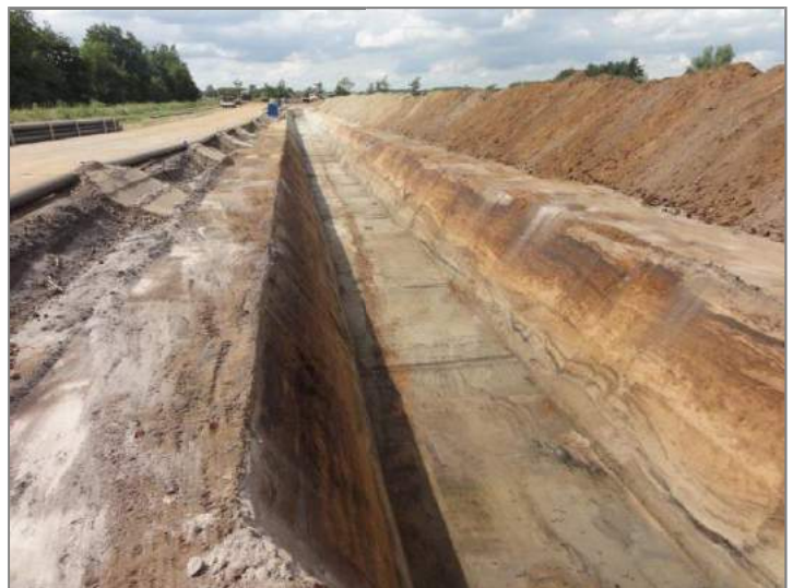
Der fertig ausgehobene Kabelgraben. Links auf dem Bild ist die Baustraße, rechts vom Graben der Aushub.
