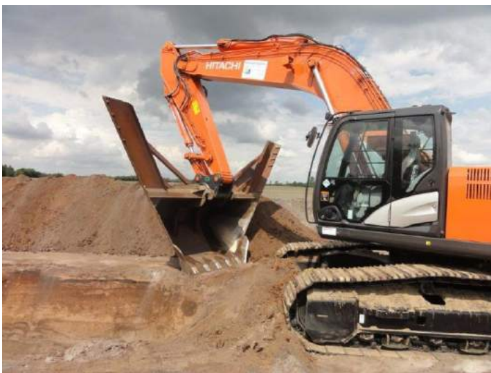
Ein spezieller Bagger hebt den Graben aus, im Hintergrund wird der Aushub gelagert.
