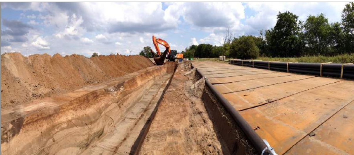
Die Baustelle in ihrer vollen Breite von 25 Metern: Ganz links befindet sich der ausgehobene Boden, direkt daneben liegt der Kabelgraben, auf der rechten Seite ist die Baustraße und am rechten Rand ist das Zwischenlager für die Leerrohre.
