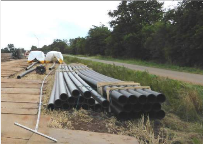
Leerrohre warten auf ihren Einsatz.
