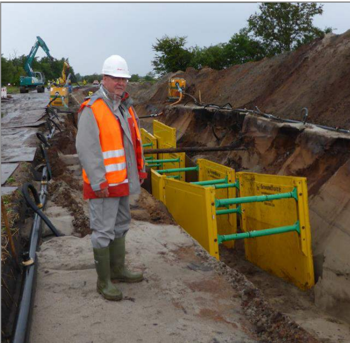
Detlef Gatzke auf der Baustelle
