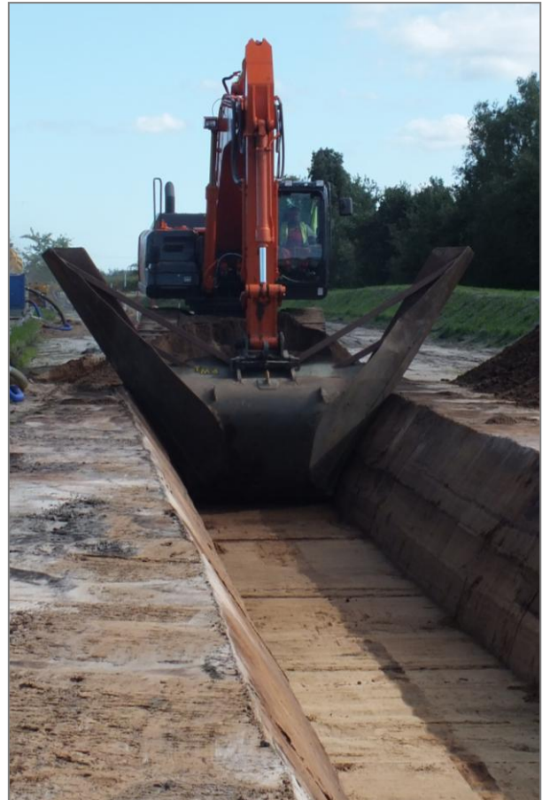
Der Bagger hebt mit einer speziellen Schaufel den Kabelgraben aus.
