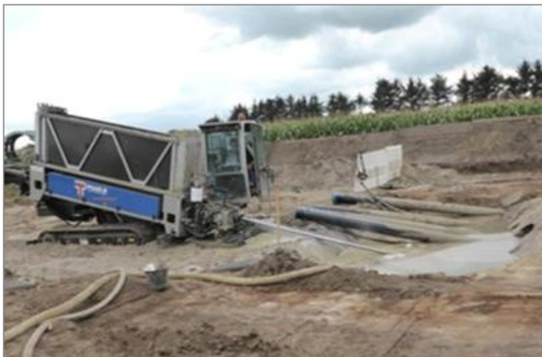
Ein Bohrfahrzeug unterbohrt einen Graben.
