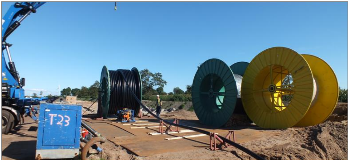
Eine 18 Tonnen schwere Kabeltrommel wird langsam abgerollt. Rechts daneben stehen zwei leere Kabeltrommeln, die ohne das Kabel noch ca. je zwei Tonnen wiegen.
