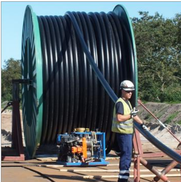
Per Funk hält der Kabeleinzieher Kontakt zu seinem Kollegen am anderen Ende des Leerrohrs, wo das Kabel wieder herauskommt.
