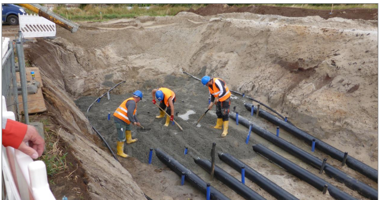
Der Ausgang der Bohrungen wird verfestigt, damit die Rohre sich in die gewünschte Richtung biegen.
