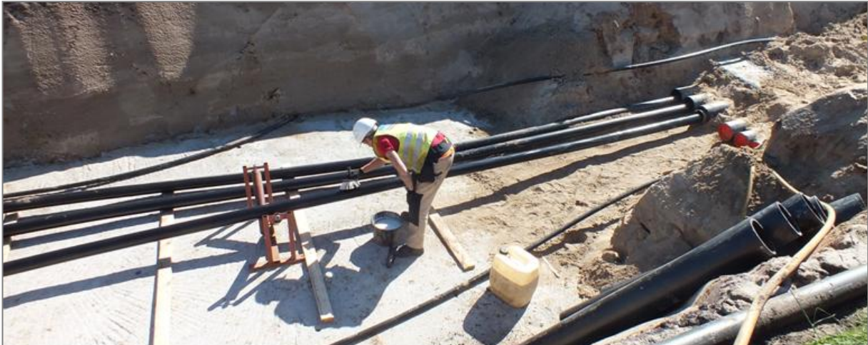
Ein Mitarbeiter fettet das Kabel während des Einzugs über die gesamte Länge, damit es besser durch das Leerrohr gleitet.
