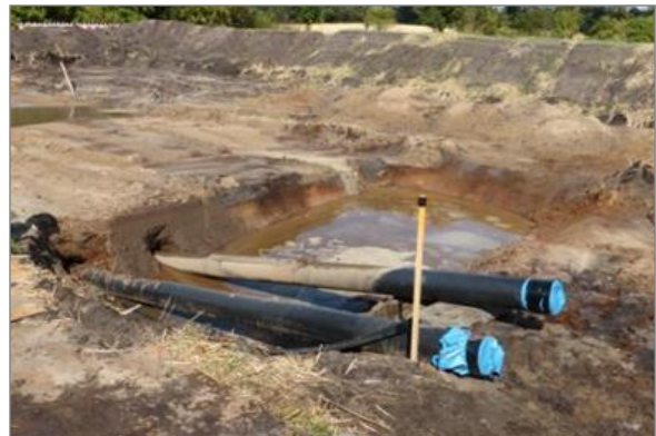
Hier liegen die Leerrohre im Bohrkanal.
