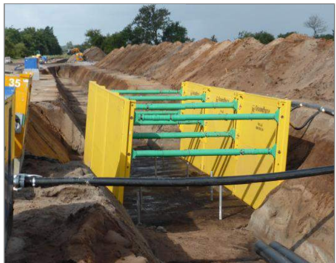
Die äußeren Wände des Verbaukastens werden als erstes aufgestellt.
