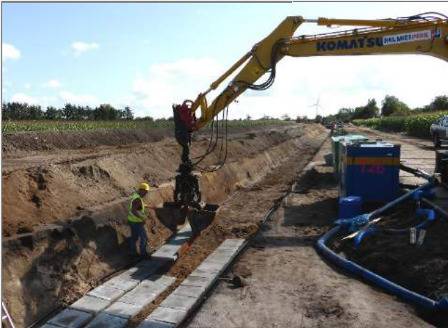
Mit Hilfe von Baggern werden die Gehwegplatten verlegt
