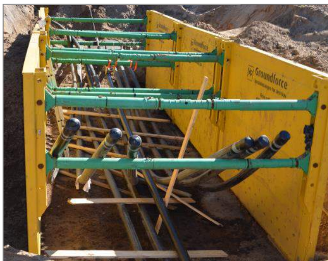
Die eingezogenen Kabel warten auf ihre Verbindung durch die Muffen.
