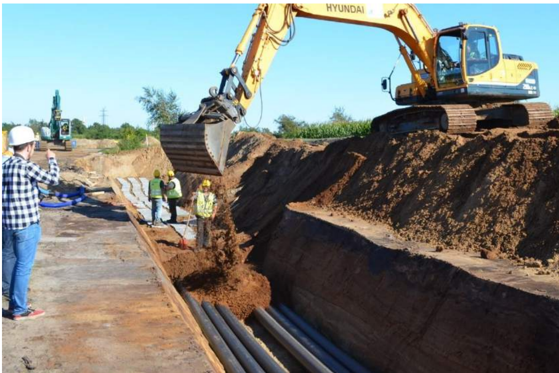
Wiederverfüllung des Grabens
