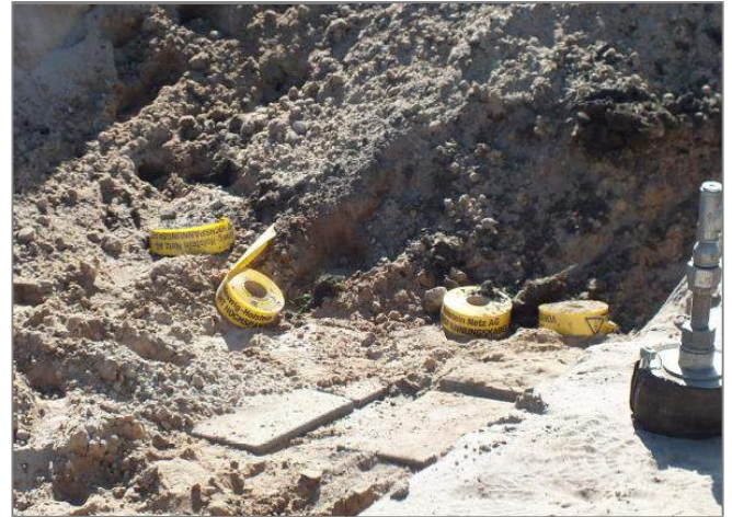
Die gelben Trassenwarnbändern markieren den Verlauf des Erdkabels
