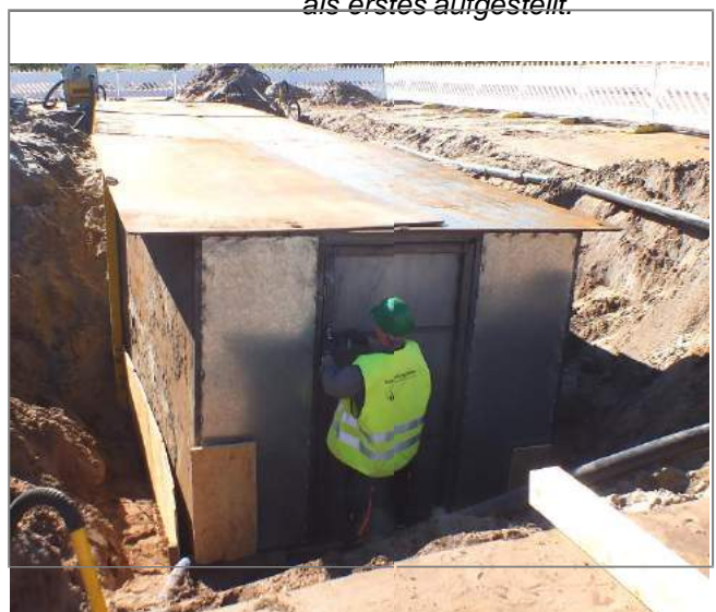
Das fertige Muffenhäuschen schützt die Arbeiten vor Wind und Wetter.
