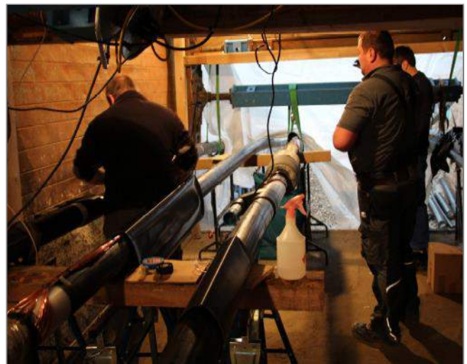
Arbeiten in der Muffengrube. Hier werden die Kabel miteinander verbunden.
