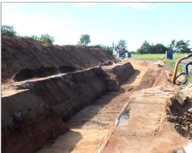
Eine breitere Stelle in der Baugrube markiert den zukünftigen Muffenstandort.
