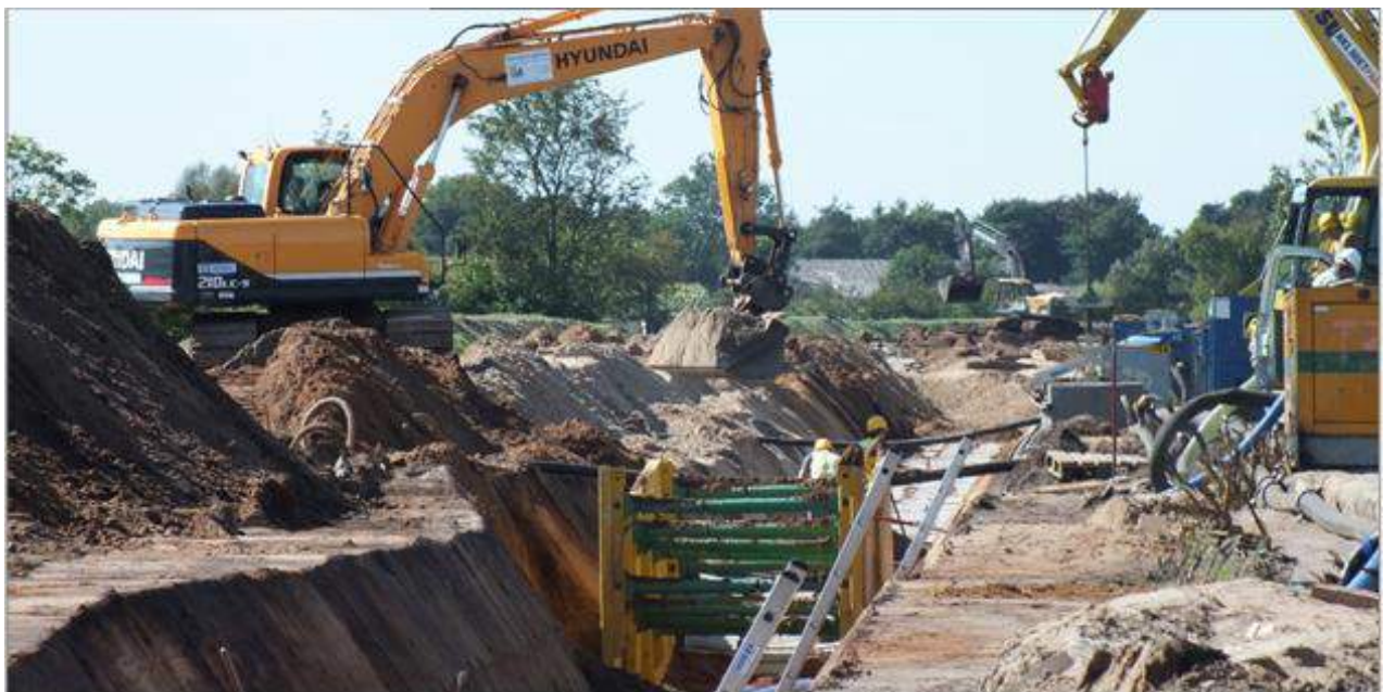
Die Bauarbeiten laufen auf Hochtouren
