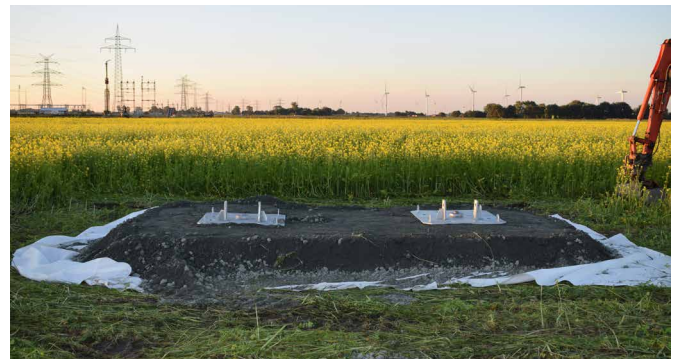
Befestigung der Spinnanker mit 7 m langen Gewindestäben
