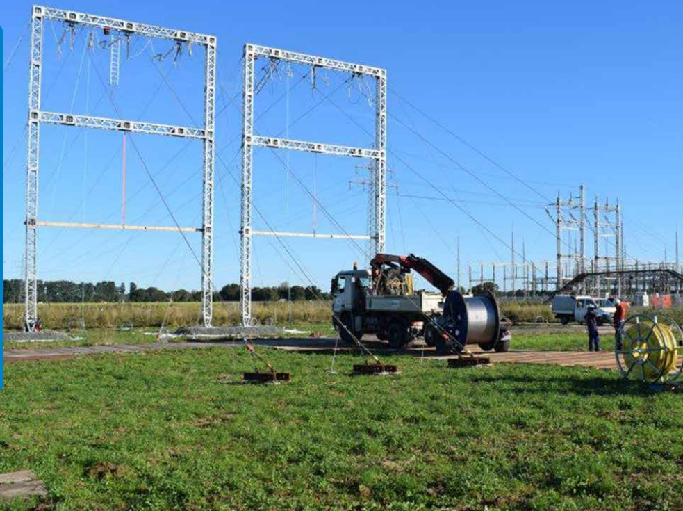
Errichtung der Portale
