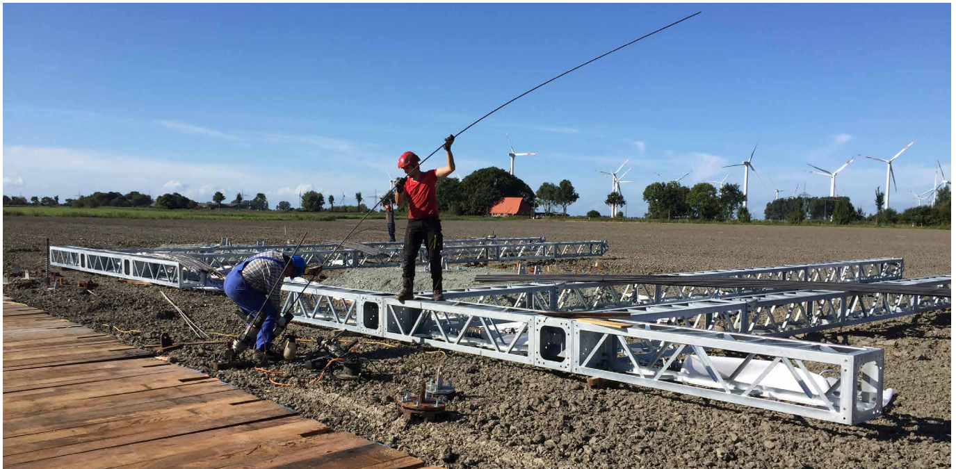
Befestigung der Spinnanker mit 7 m langen Gewindestäben
