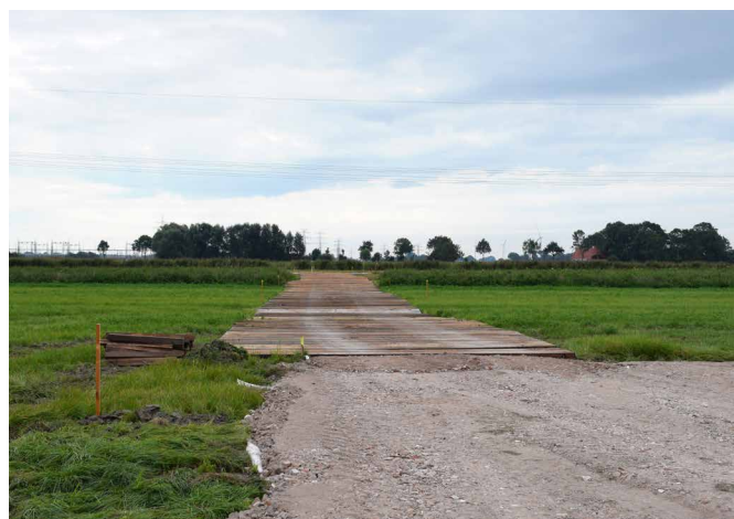
Wegebau mit Baggermatten und Aufschotterung
