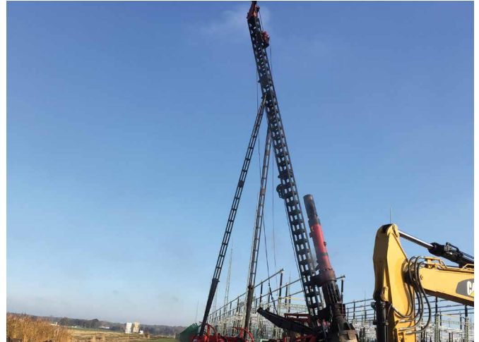
Ein Stahlrohr wird gerammt
