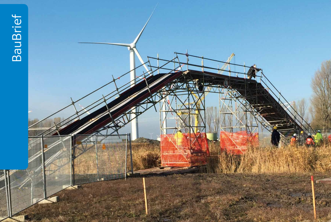
Kabelbrücke über die Draisinenbahn
