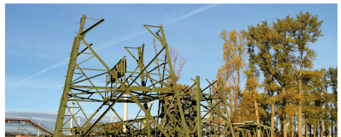
Rückbau eines Mastes
