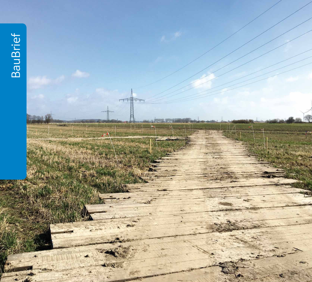
Die Wege werden durch Baggermatten geschützt
