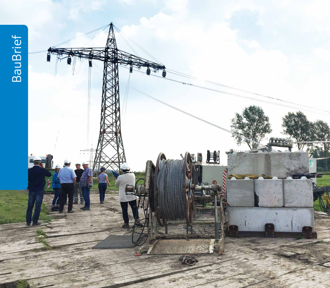
Seilzugarbeiten an einem neu errichteten Mast
